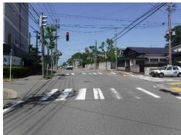
▲川尻総社通り線(現況)
