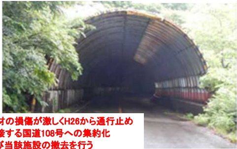
R8年度:撤去工事
