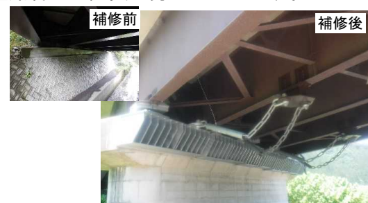
橋梁補修工(国道108号 新川井橋)
