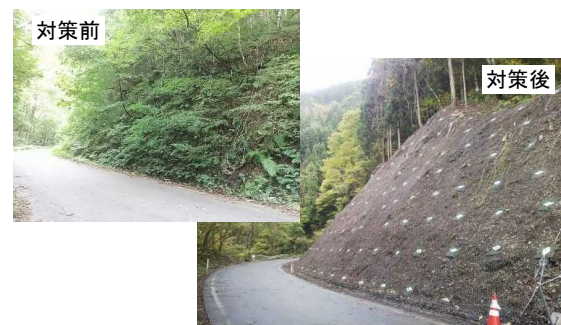
法面保護工((-)河辺阿仁線)
